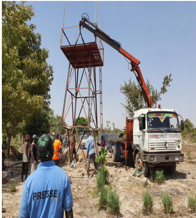
Suite des travaux de fouille et l'implantation du support de château de 5m2.
