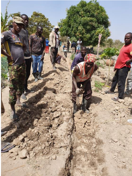
Suite des travaux de fouille et l'implantation du support de château de 5m2.
