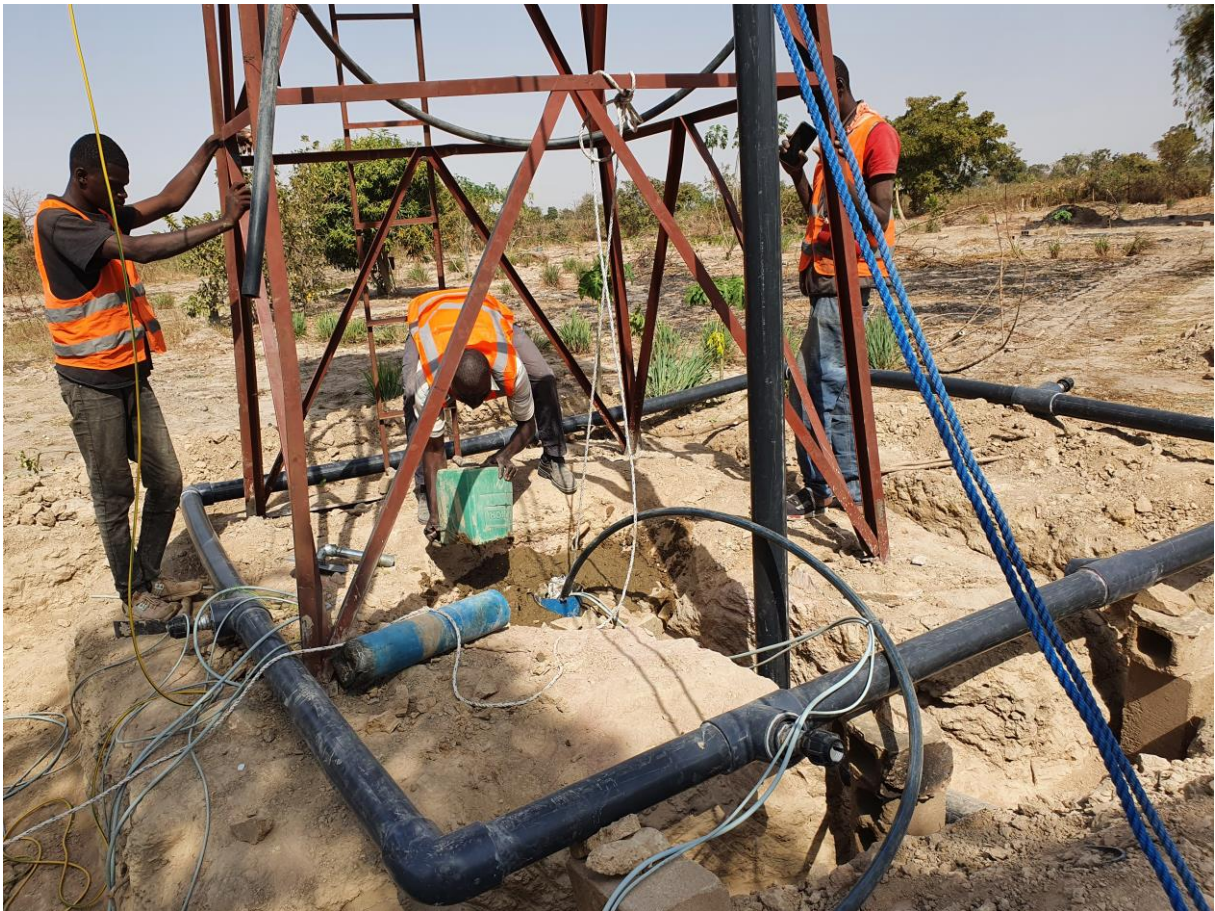
Suite des travaux d'installations du forage reliant à la distribution.
