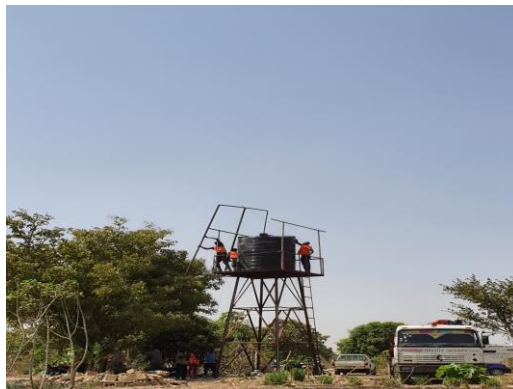
Suite des travaux de fouille et l'implantation du support de château de 5m2.
